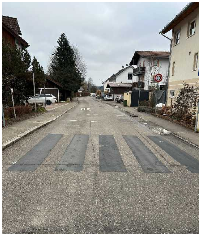
Der ehemalige Zebrastreifen an der Eglhartinger Straße in Pöring war laut Gemeindeverwaltung nicht mehr „rechtskonform“ und musste deshalb rückgebaut werden. (Foto: Ludwig Pelzer)
