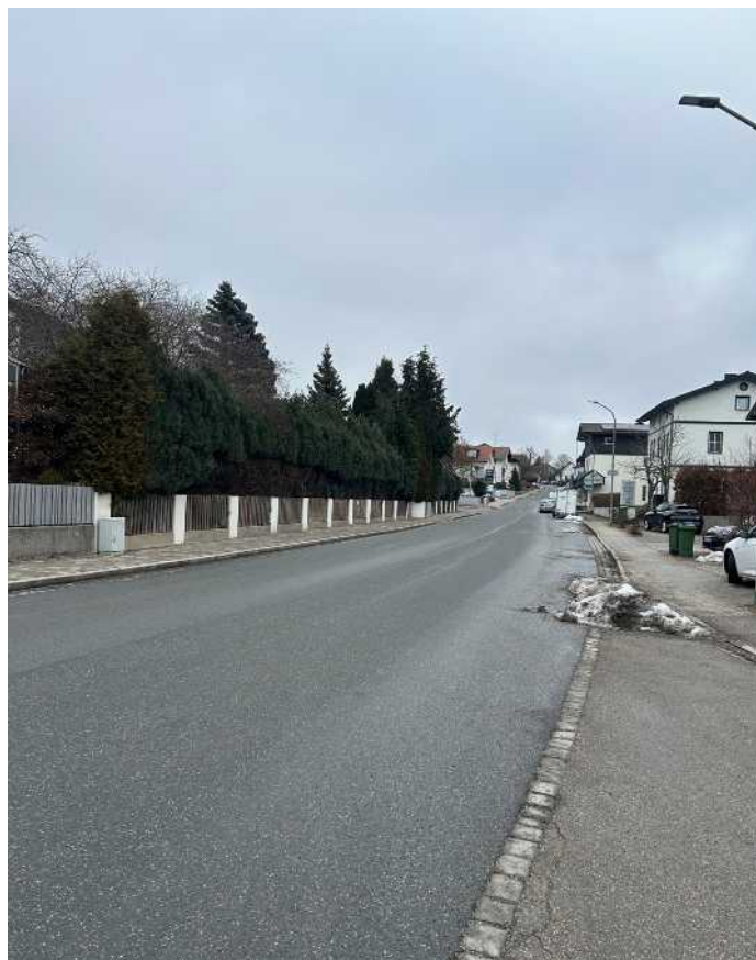
In diesem Bereich der Münchner Straße beim Neuwirt (in Blickrichtung nach Osten fotografiert) wäre vielleicht ein Fahrradschutzstreifen realisierbar. Ab der Bahnhofstraße wird es wesentlich enger. Dies brächte auf der Fortführung als Wasserburger Landstraße erhebliche Parkplatzprobleme für beispielsweise Anlieferungen durch unsere Nachbarschaftshilfe. (Foto: Ludwig Pelzer)
